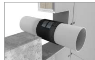
Fertige Wicklung mit Gewebiband und an den Außenseiten mit Kabelbindern fixieren s.u.
