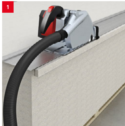
Aestuver® Brandschutzplatten werden mit schienengeführter Handkreissäge zugeschnitten
