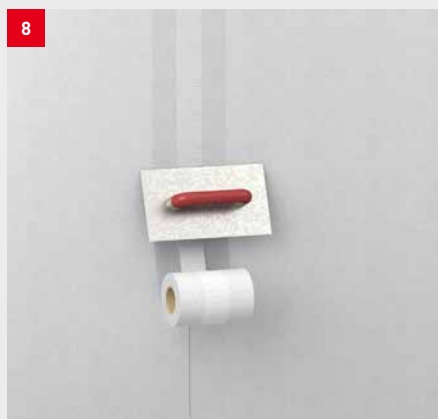
Aufbringen des fermacell Armierungsbandes HD
