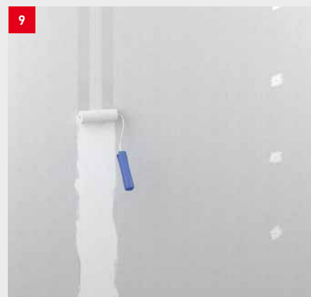
Aufbringen des fermacell Armierungsklebers HD
