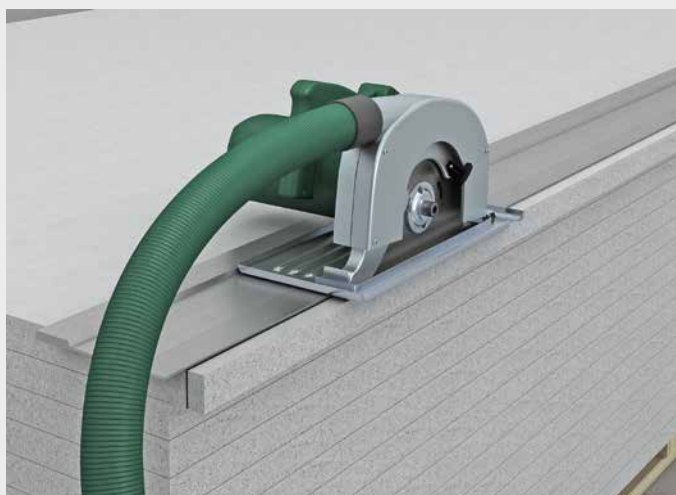
AESTUVER Brandschutzplatten werden mit schienengeführter Handkreissäge zugeschnitten
