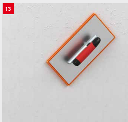
Abfilzen des fermacell Leichtmörtels HD
