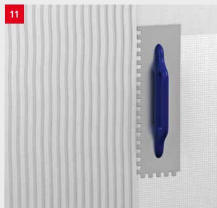
Verlegung des fermacell Armierungsgewebes HD in das Mörtelbett
