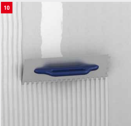
Aufbringen des fermacell Leichtmörtels in Bahnbreiten des Armierungsgewebes
