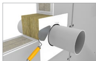
Lissage de la surface
