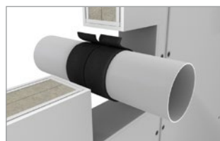
Enroulement des deux côtés* autour du tuyau inflammable, à fleur avec la surface de cloisonnement
