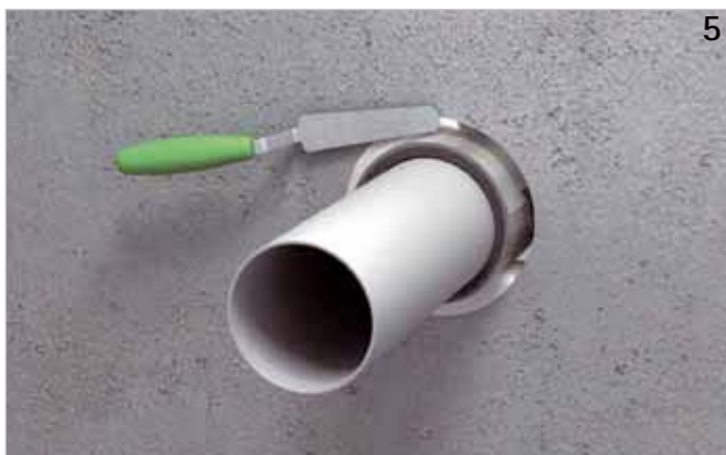
Restpalt rauchgasdicht (mit Tangit® FP 550 oder Tangit® FP 300) verschließen.
