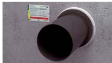
Verschluss von Rest- bzw. Ringspalten oder Durchbrüchen mit Tangit® FP 550 Brandschutz- Schaum
