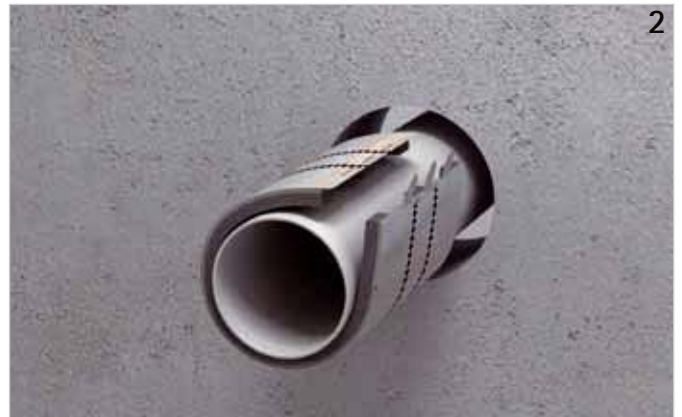
Manschette um das Rohr legen.
