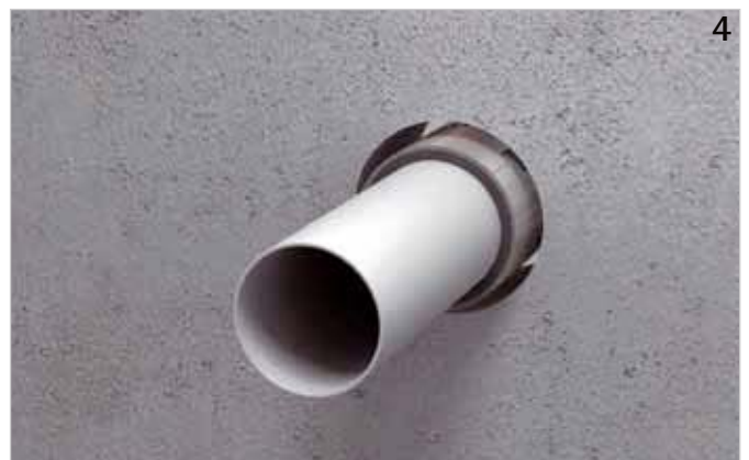
Manschette in die Bauteilöffnung schieben. (Überstände beachten!)
