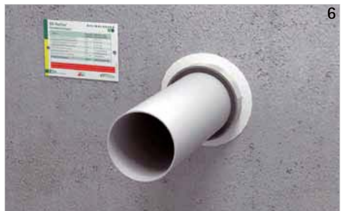
Das Universalschild ausfüllen und neben der Abschottung anbringen. (Bei Verwendung von Tangit® FP 550 muss das Tangit® Universalschild angebracht werden!)
