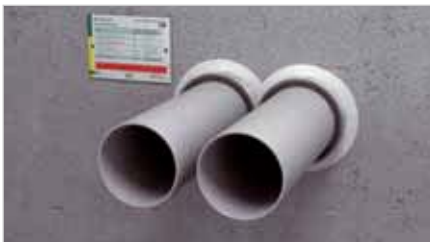
Nullabstand in Massivbauteilen
