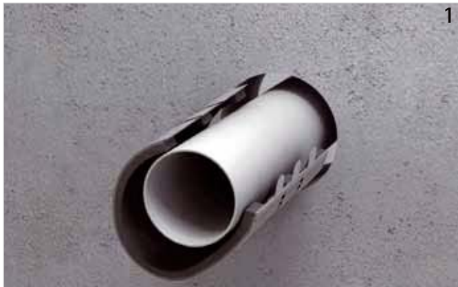
Rohrleitung installieren und Manschettengröße auswählen.
